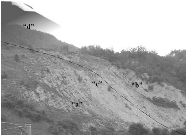
Figura 9. Vista generale del fronte di scavo: “a” strati inclinati; “b”: strati molto inclinati; “c”: frana rotazionale; “d”: modello numerico ad elementi finiti. Il tratteggio indica una zona di taglio tettonico.
