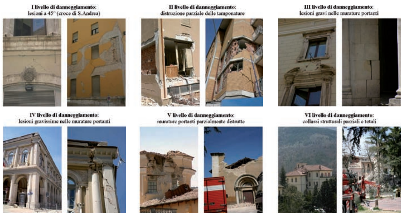
Fig. 9 - Classificazione sistematica dei livelli di danneggiamento strutturale
