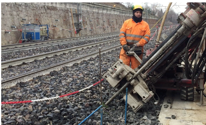
Figura 4 – La perforazione ad aria compressa consente un'elevata produttività e snellezza delle lavorazioni.
