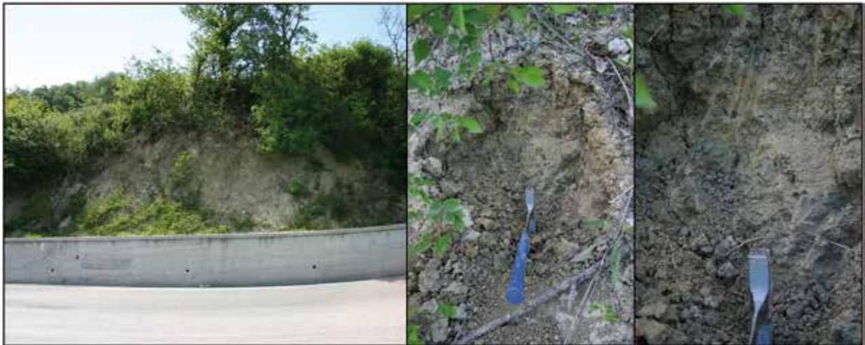
Fig. 3 – Effetti dell'alterazione di una scarpata impostata su marne del Messiniano che, a soli due anni dalla sua profilatura, ha interessato una profondità di circa 40 centimetri.
